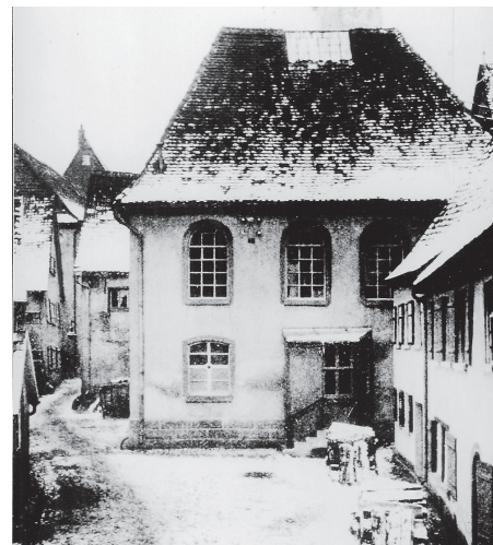
Bei der Gedenkfeier am 9. November wird an die Reichspogromnacht erinnert, als in vielen Städten Deutschlands jüdische Gotteshäuser gestürmt, ausgeraubt und angezündet wurden. Foto: Stadtverwaltung
