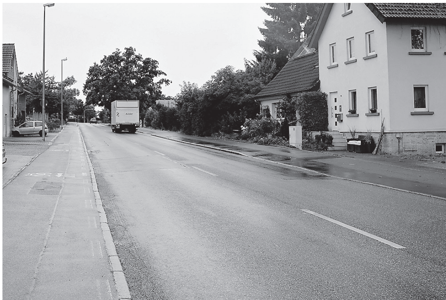
Ab der Kreuzung Hofwiesenstraße/Haller Straße wird stadtauswärts saniert. Foto: Stadtverwaltung
