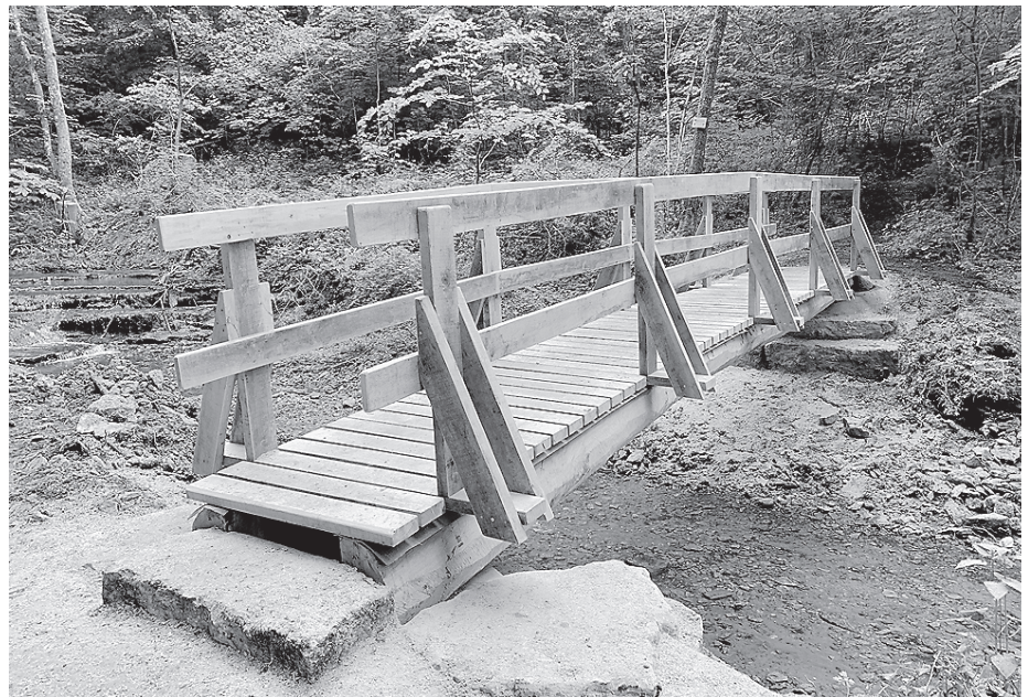
Die Brücke über den Schmiedebach erstrahlt in neuem Glanz.
