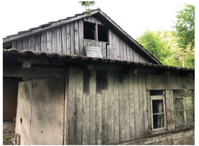
Abb. 10: Holzscheune an dem zum Abriss vorgesehenen Gebäudekomplexes
