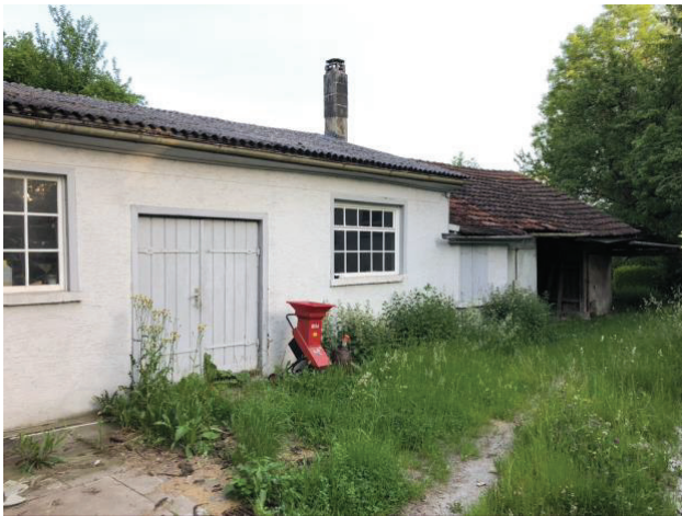
Abb. 9: Teil des zum Abriss vorgesehenen Gebäudekomplexes
