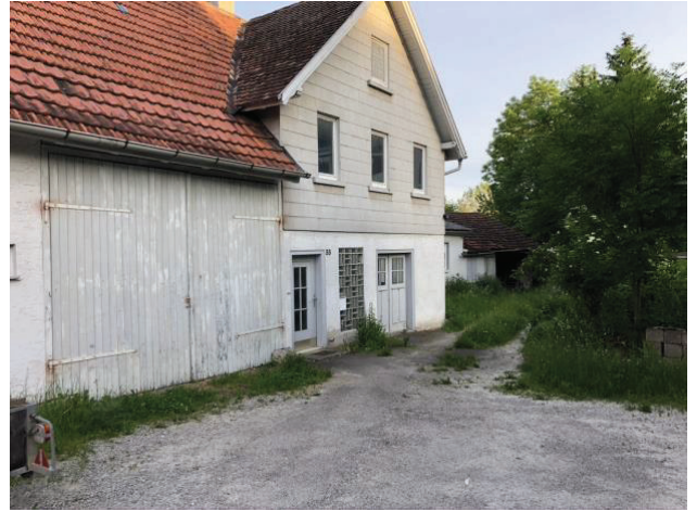
Abb. 8: zum Abriss vorgesehener Gebäudekomplex
