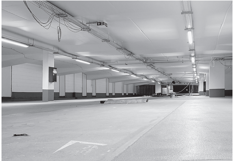
Auch der Boden und die entsprechenden Markierungen stehen bei der Sanierung der Tiefgarage noch an. Foto: Stadtverwaltung
