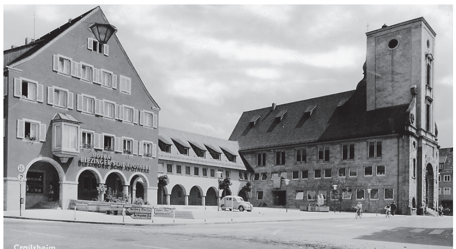
Der Crailsheimer Rathhausturm zählt zu den markanten Wahrzeichen der Stadt und kann im Rahmen von Führungen am Tag des offenen Denkmals besichtigt werden.
