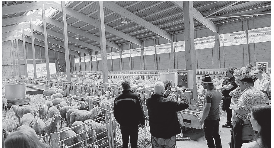
Der neue Schafstall wurde Ende 2025 fertiggestellt, ist hochmodern und lichtdurchflutet. Fotos: Stadtverwaltung
