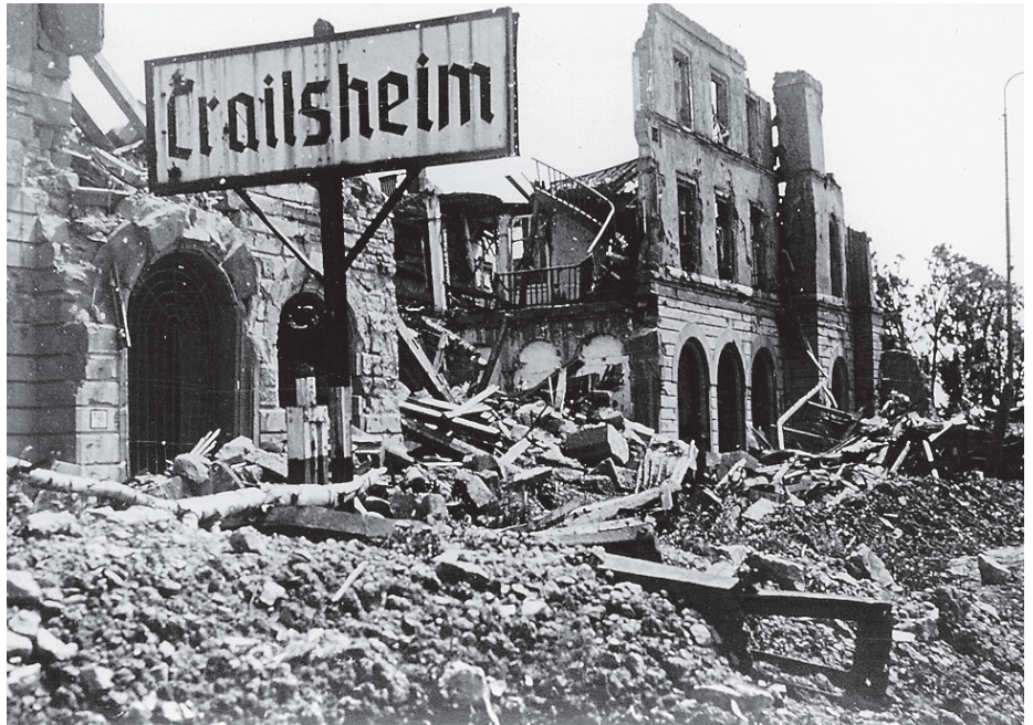
Auch der Crailsheimer Bahnhof wurde nahezu komplett zerstört.
