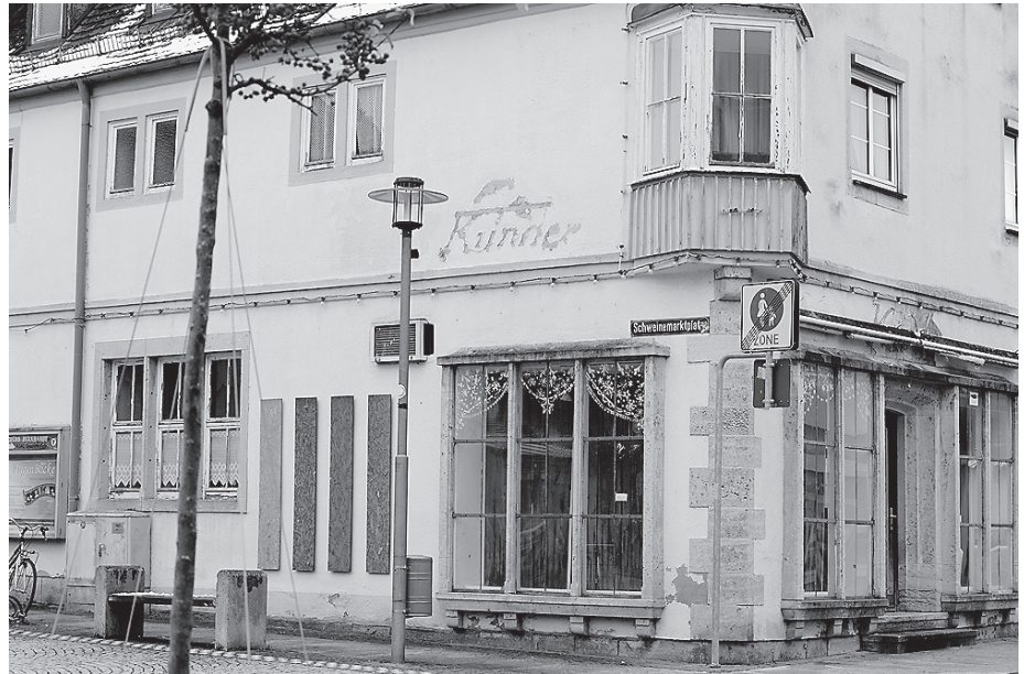
Außerdem gab es Fragen zum Abriss des Kunder-Hauses.
