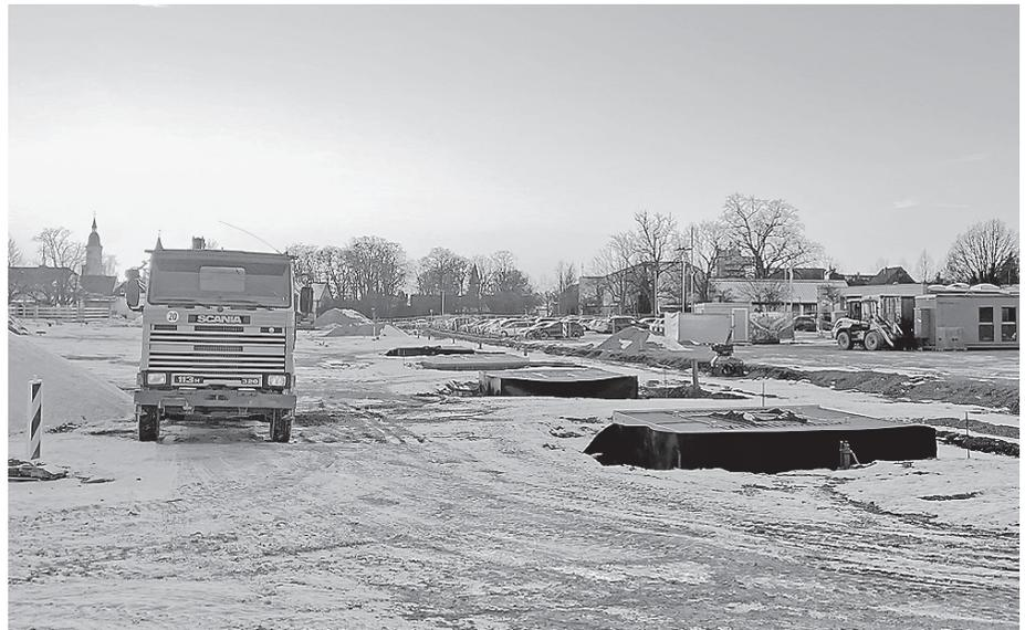
Die Schutzkäfige für das Wurzelwerk werden bei der Sanierung des Volksfestplatzes bereits mitinstalliert. Foto: Stadtverwaltung
