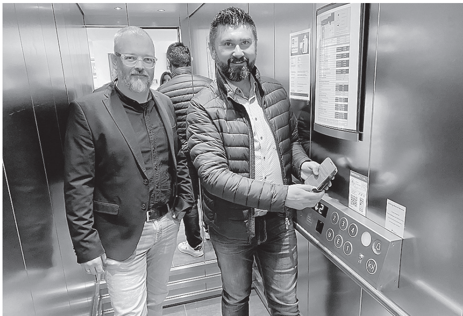
Ressortleiter Götz Förg und Adrian Gollasch testen in einem städtischen Aufzug das neue System.
