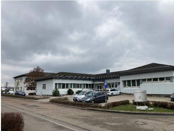
Abbildung 2: Bürogebäude Firma Schubert
