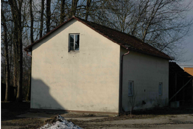
Abb. 11: Gebäude mit Einflugmöglichkeit an Fenster
