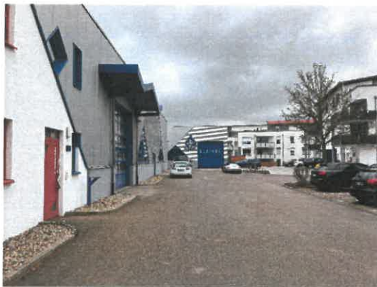
Abbildung 4: Innenhof zwischen Hallen und Goldbacher Straße 81 und 83
