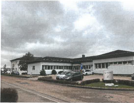
Abbildung 2: Bürogebäude Firma Schubert
