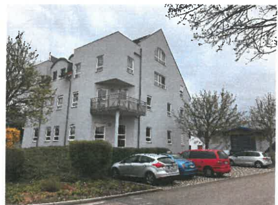
Abbildung 5: Wohngebäude Goldbacher Straße 81
