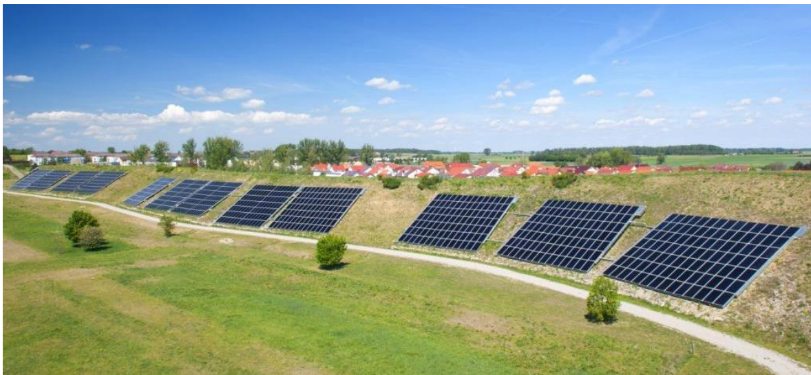
Abbildung 55: Kollektoren auf dem Schallschutzwall kurz nach der Fertigstellung
