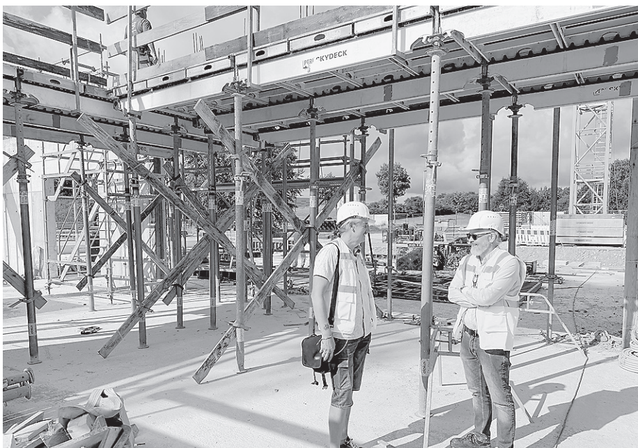
Stehen im späteren Foyer (von links): Gerd Großmann und Götz Förg sind mit dem bisherigen Verlauf der Arbeiten sehr zufrieden.
