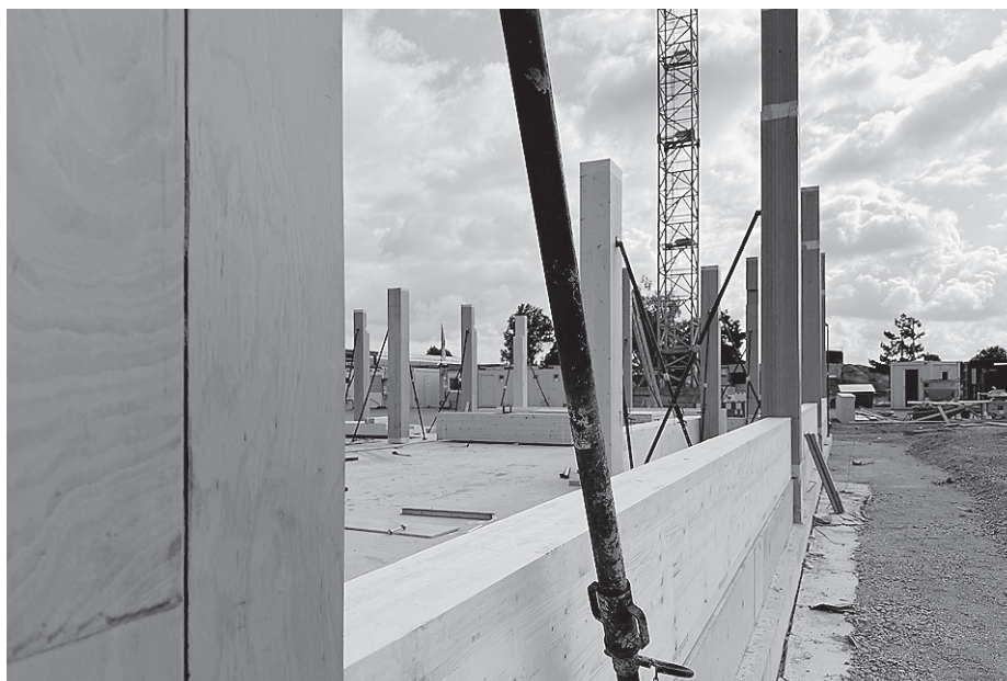
Teile des Holzkerns der Außenwand sind bereits angebracht, ebenso stehen die ersten Holzträger im Innenbereich. Fotos: Stadtverwaltung
